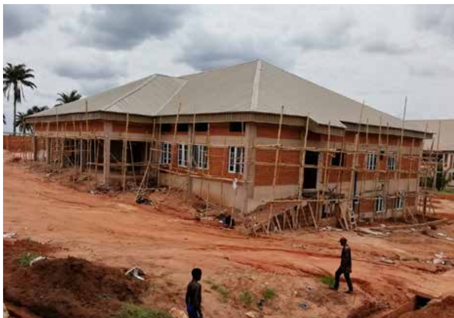
Aula der MOCTECH zum Baustopp im März 2020.
